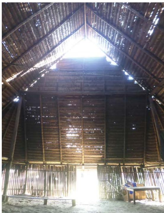
Figura 6. La cubierta se eleva en diagonal y arriba cerca de su cúspide triangular tiene unas aberturas para permitir el acceso de la luz del sol y la contemplación del firmamento, así como la salida del humo de los cocimientos que se hacen en su interior.
