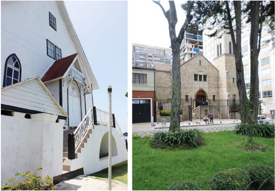
Figuras 167 y 168. La utilización del recurso que separa las iglesias del nivel del piso.
