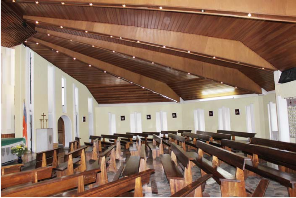
Figura 100. Interior de la iglesia episcopal anglicana San Pablo, en el que se destaca el cielo raso de madera de la cubierta, y al fondo las ranuras en el muro que permiten recibir una iluminación natural indirecta sobre el espacio. Bogotá.
