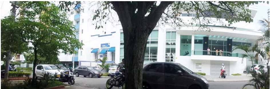
Figura 187. Los materiales de fachada y el lenguaje formal en general utilizados consiguen que estas arquitecturas se mimeticen dentro del contexto urbano en el que se encuentran.
