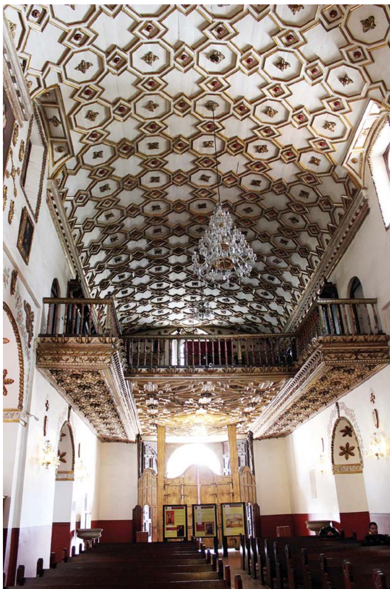
Figura 35. Vista del coro, bajo el que se observa el cancel de madera que controla el “paso” entre interior y exterior. El manejo de la iluminación natural controlada contribuye a acentuar el carácter de serenidad y recogimiento en el interior del espacio.
