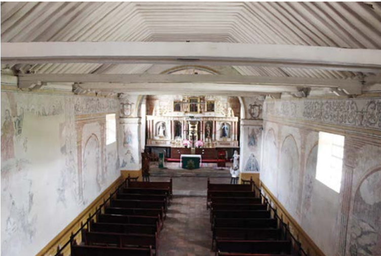
Figura 21. Nave y estructura de madera en par y nudillo sobre la que reposa la cubierta de la iglesia doctrinera de Sutatausa. En primer plano, los tirantes de la estructura de madera.
